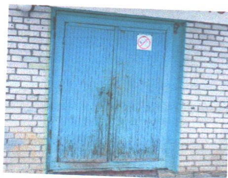
Фото №4 – Наружная входная дверь
