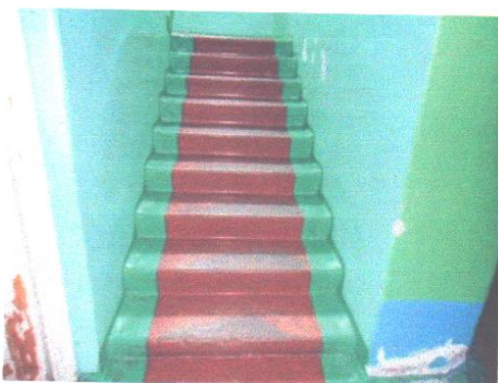
Фото №8 - Внутренние лестницы
