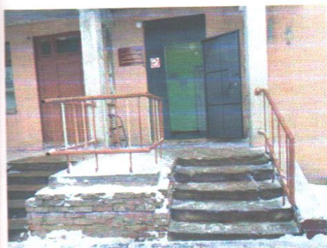
Фото №3 – Входная площадка, лестница (наружная)
