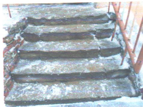
Фото №4 – Лестница (наружная)
