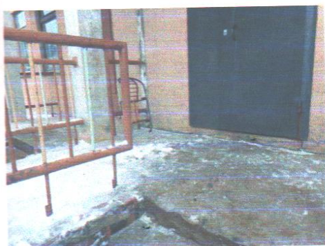
Фото №5 – Входная площадка, лестница (наружная)
