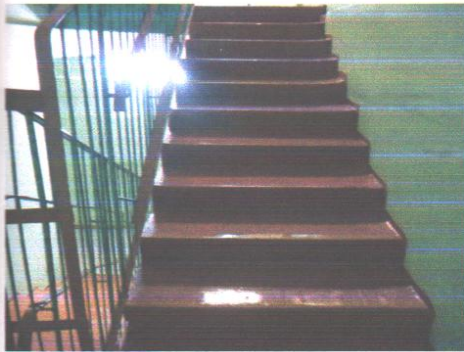
Фото №12 – Внутренние лестницы (междуэтажные)
