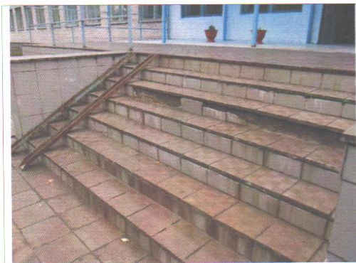
Фото №4 – Наружная лестница главного входа
