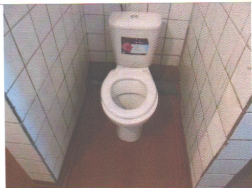
Фото №25 – Санитарно-гигиеническое помещение (туалетная кабина)
