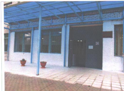
Фото №6 – Входная площадка главного входа
