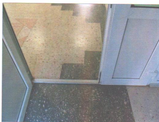
Фото №9 – Внутренняя входная дверь
