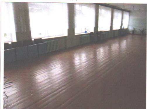
Фото №12 – Путь (пути) движения внутри здания
